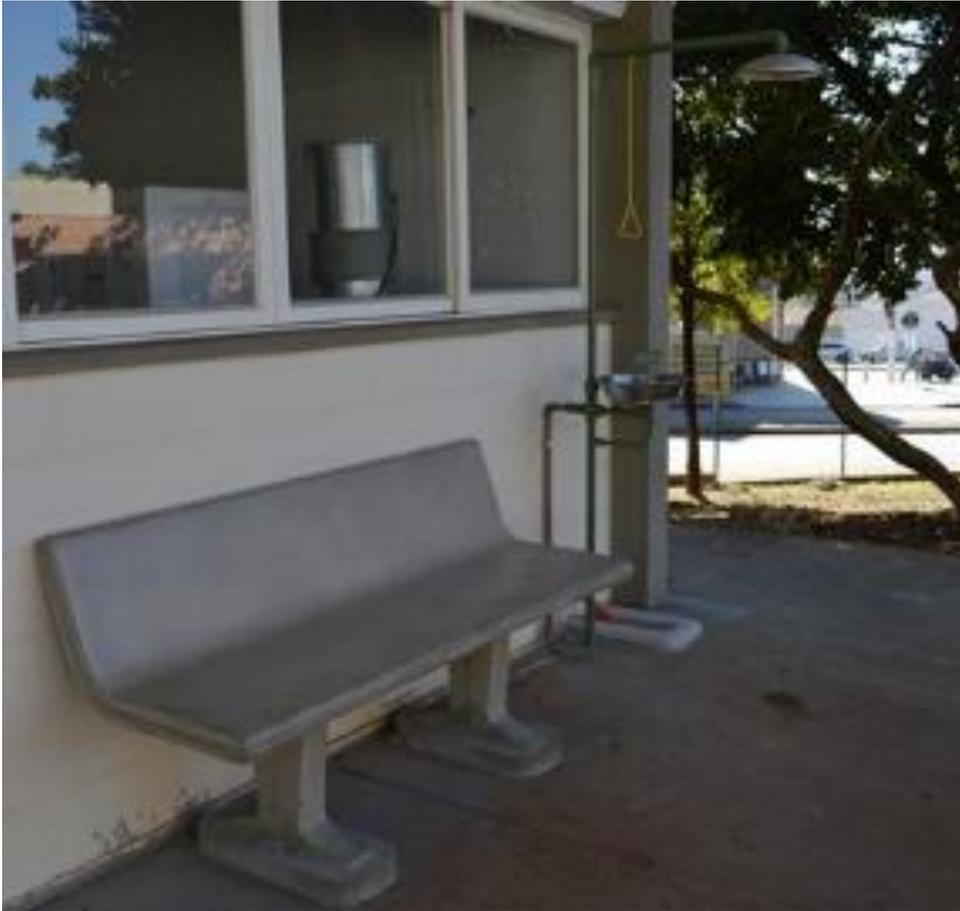
*Figura 29 - Instalação do Lava Olhos externamente, para otimização dos espaços e criação de novo laboratório de Pesquisa*
