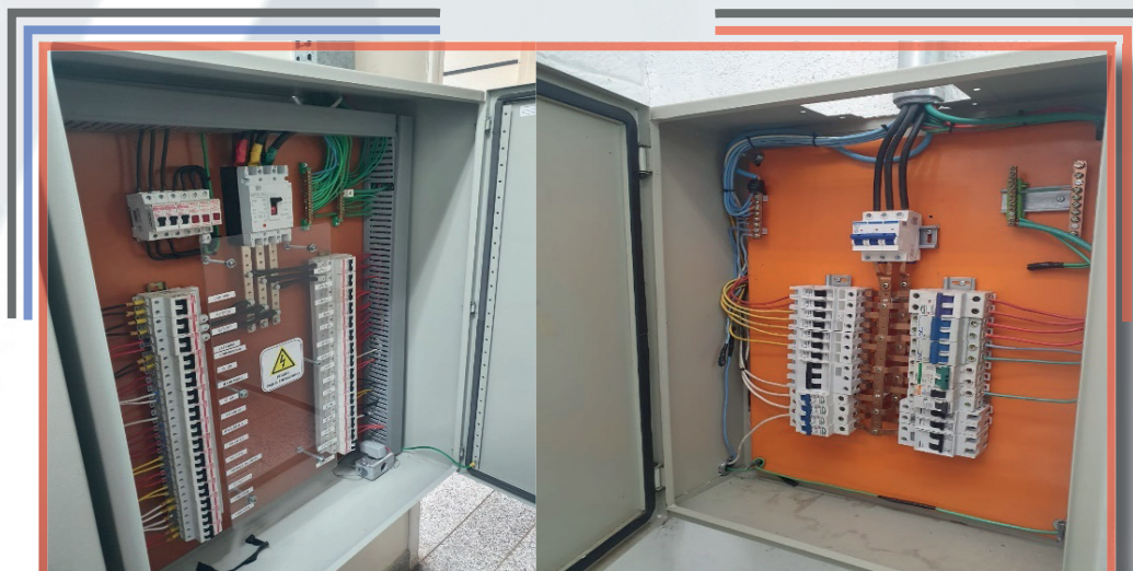
Substituição de quadros elétricos em laboratórios de pesquisa da FT
