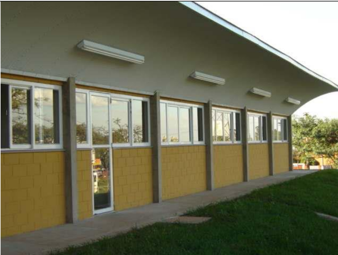
Figura 2. Vista externa do prédio do Laboratório de Telecomunicações.
